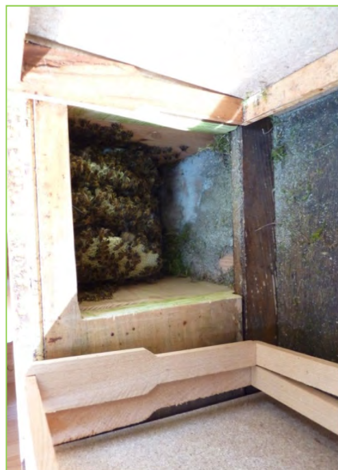
Ein Mauerseglerkasten wurde von einem Bienenvolk bewohnt.
