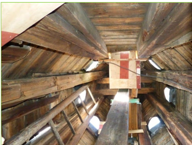
Einbau der Dohlenkästen im Johannesturm
